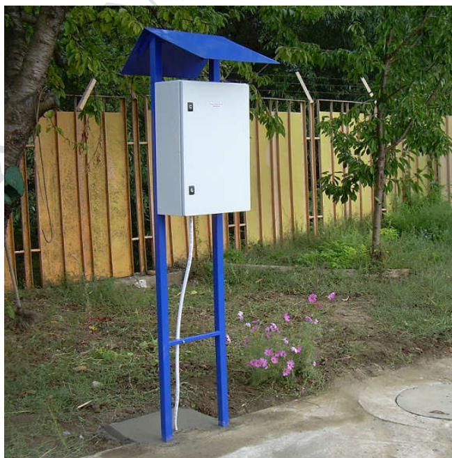
Фиг.2.6 Защитен шкаф със стойка.
